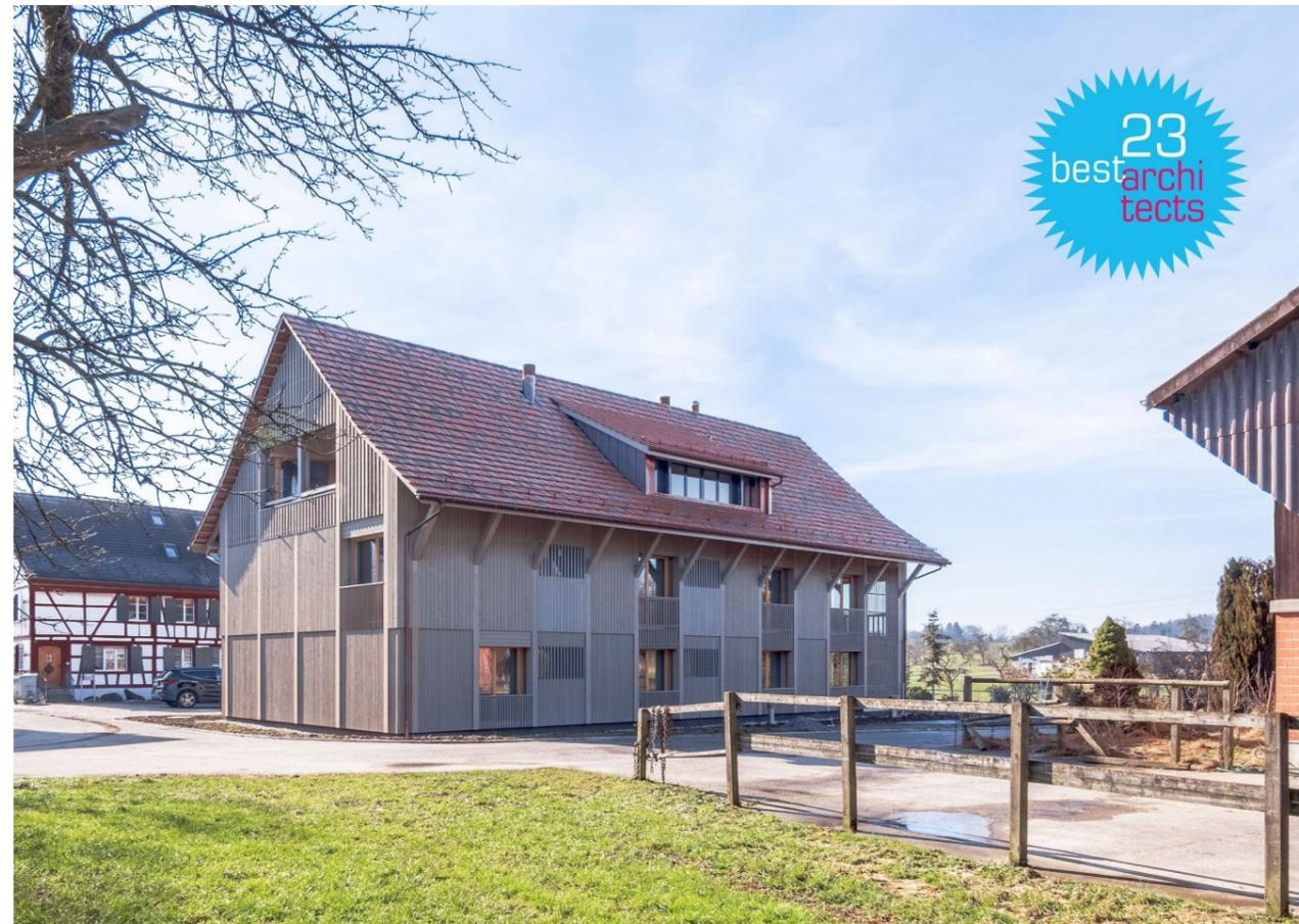
Das dreigeschossige Wohnheim beheimatet vier Wohngruppen und schließt im rechten Winkel an den bestehenden, eingeschossigen Zwischenbau an. Das Kellergeschoss und das Treppenhaus wurden in Stahlbeton erstellt. Darauf steht ein Holztragwerk mit sichtbaren Holzwänden, Decken und Fassadenornamenten. Über ein lichtdurchflutetes Treppenhaus mit Sichtbezug zum Hof werden die geschossweise organisierten Wohngruppen erschlossen.
