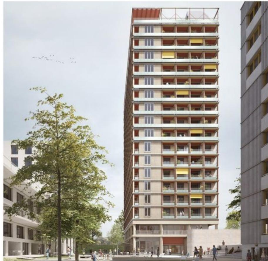
Das 18-geschossige Holzhochhaus befindet sich auf dem Holliger-Areal, Baufeld O1 in Bern. Der zweigeschossige Sockel nimmt überwiegend gewerbliche Funktionen auf, die Hauptnutzung ist Wohnen. Ab dem 2. Obergeschoss ist das Tragwerk in sichtbarer Holz- bzw. Holz-Beton-Verbundbauweise konzipiert, die Sockelgeschosse und der Erschliessungskern in Massivbauweise.
