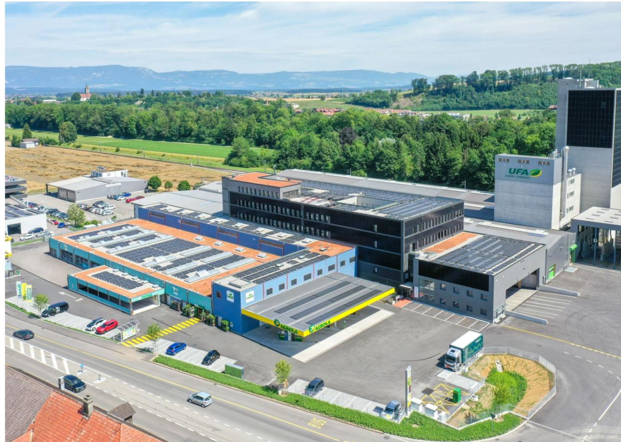
Das neue Leistungszentrum der fenaco Genossenschaft ist ein beeindruckendes Lager- und Bürogebäude mit vier Etagen. Seine Aussenmasse betragen 130 x 28 Meter und die maximale Gebäudehöhe beläuft sich auf 21 Meter. Das gesamte Gebäude wurde als Holzskelettbau konzipiert. Besonders bemerkenswert sind die 22 Meter langen freitragenden Fachwerke, die drei Bürogeschosse tragen, sowie die A-Streben im Erdgeschoss, mit welchen die Wind- und Erdbebensicherheit gewährleistet wird.
