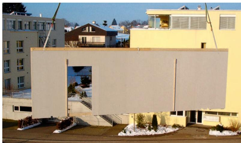
Ausgehend von den Projektvorlagen (oben die Darstellung des Querschnitts) über die Visualisierungen im 3D-Format (die Explosionszeichnung zeigt die fünf Geschosse und das Dach) führte der Weg der Materialisierung zur Vorfabrikation meist grossformatiger Holzbauelemente (links).
