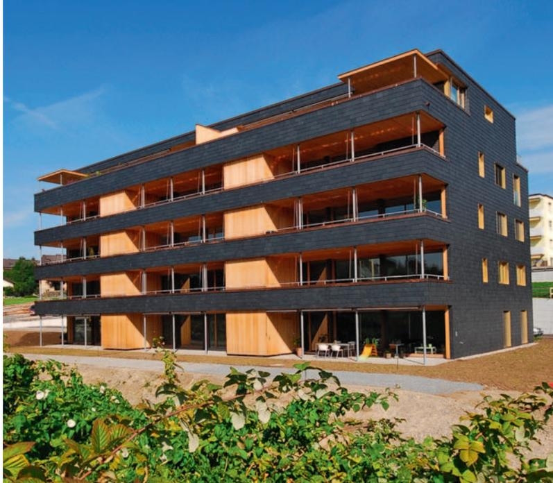
Auf einem zentral gelegenen Gelände in Gossau SG ist die Überbauung Aatal-Weiher im Entstehen begriffen. Sie umfasst drei Mehrfamilienhäuser mit je fünf Geschossen, auf die insgesamt 42 Wohnungen verteilt sind. Nach dem Standard Minergie-Eco konzipiert, hat die Projektrealisierung in Holzbauweise mit einem ersten Haus seinen Anfang genommen.
