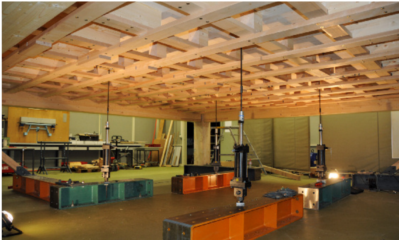
Versuchsaufbau der Holzdecke. Ansicht auf die Buchenholzlamellen der Holzdecke. Bilder: ETH IBK, Zürich
