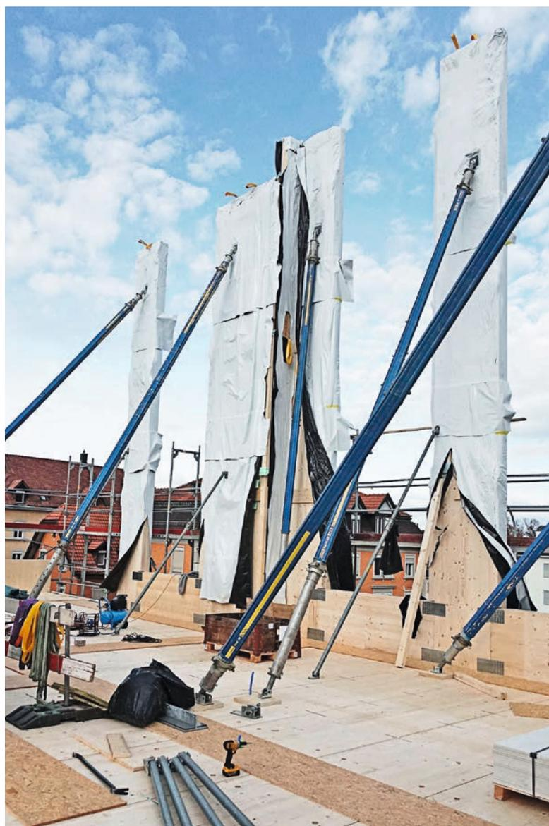
Die vertikalen Vierendeel-Elemente wurden vorgängig über alle fünf Geschosse aufgerichtet.
