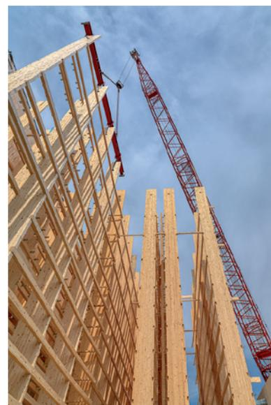
*Die einzelnen Regalteile sind im Werk in Davos vorgefertigt und dann in einer Feldwerkstatt vor Ort in Wallisellen zu Teilstücken zusammengebaut worden. Mit einem Raupenkran wurden sie millimetergenau versetzt.*
