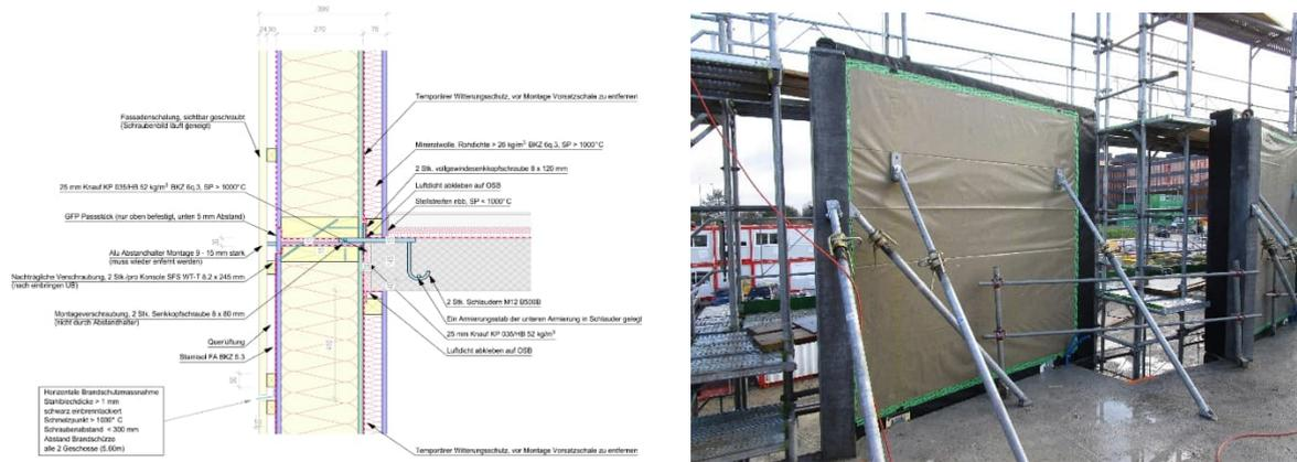
Abb. 3: Vorgängig montierte, nicht tragende Aussenwandkonstruktion (anspruchsvolle Fassadengeometrie)
