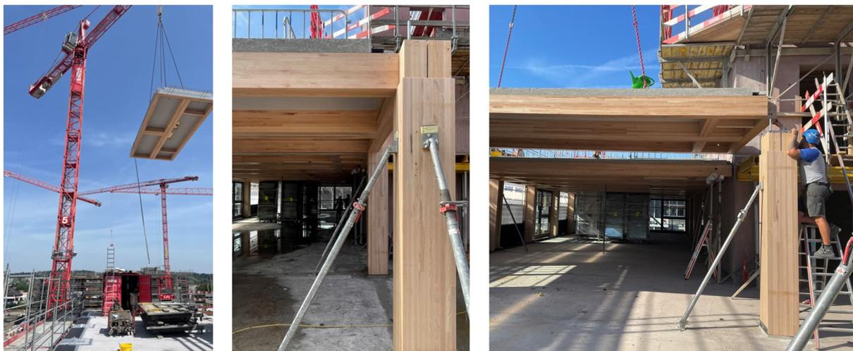
Abbildung 13: Montage Deckenelemente
