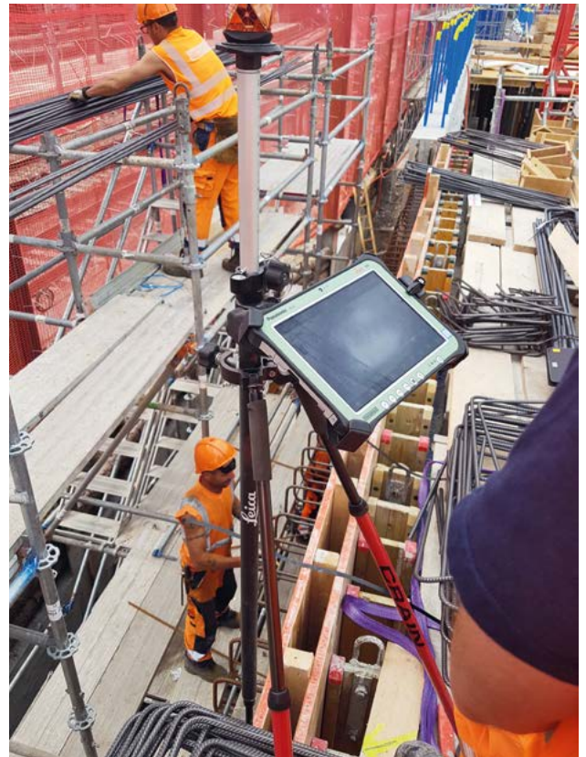
Via Stick oder online werden die georeferenzierten Daten auf das Tablet der Robotikstation (links) geladen für das Einmessen von Punkten, Linien und Höhen (oben rechts). Nicht nur der Polier, auch der Eisenleger arbeitet mit dem Tablet (oben links).
