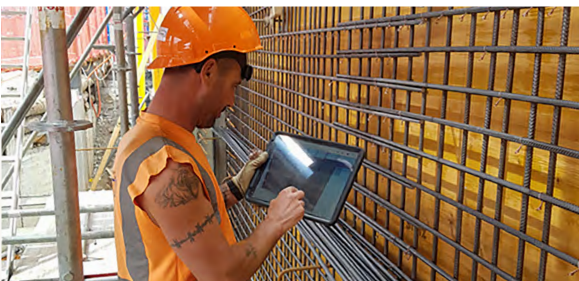
Logistikzentrum und Erweiterung Radweg Winterthur, Ausführung der Bewehrung ab Modell
