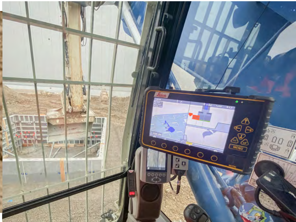
Anwendungsbeispiel Baustelle Baggersteuerung vom BIM Modell
