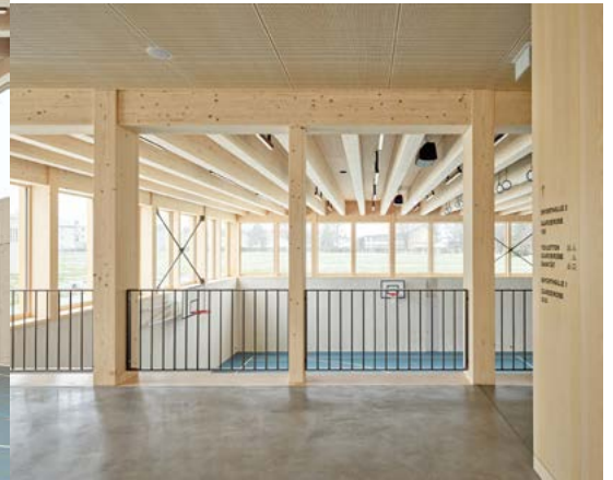
Sporthallen BZT Frauenfeld, Aussen- und Innenansichten Bilder: Roland Bernath, Zürich
