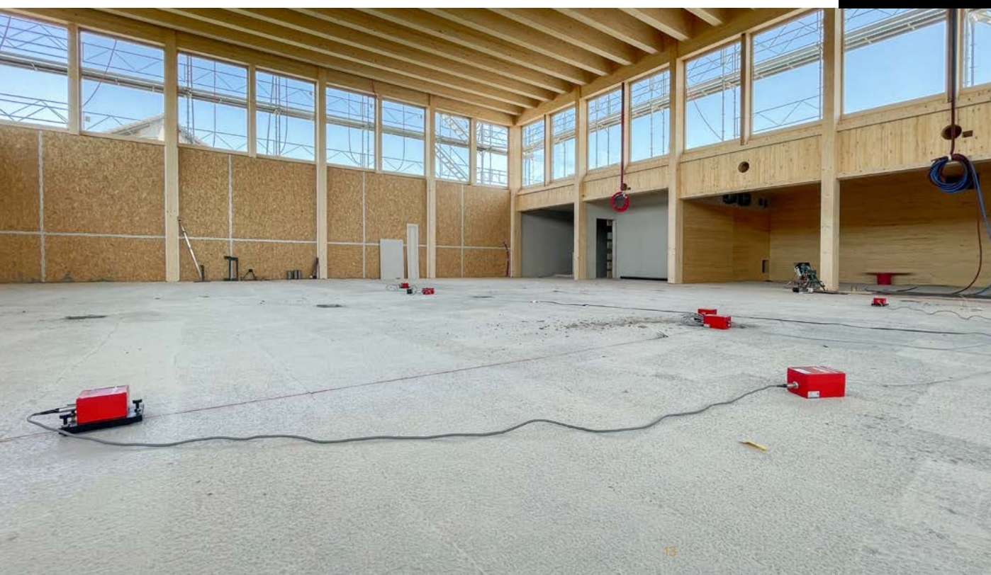
Sporthallen BZT Frauenfeld, Schwingungsmessung Turnhallendecke
