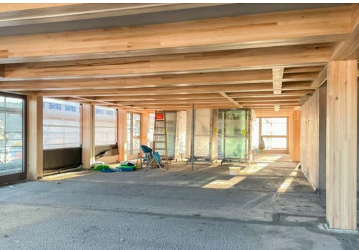
Hochhaus H1 Zwhatt-Areal Regensburg, Rohbaumontage
