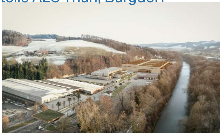
Ausbau Aussenstelle ALC Thun Burgdorf, Visualisierung Gesamtgelände Bild: Trunz Wirth, Henau
