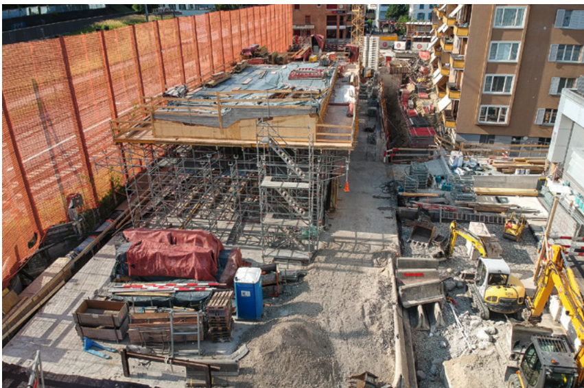
Baustelle des neuen Busbahnhofs in Adliswil
