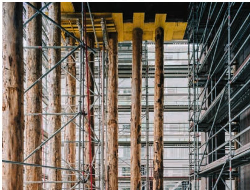
**Um die Schalung für die Auskrugung des dreigeschossigen Betonsockels zu stützen, bedurfte es rundherum massiver Baumstämme.** Im fertigen Zustand stützen nur noch zwei Betonstützen zum Platz und jeweils drei an den Seiten das Betontableau, auf dem sich 21 Wohngeschosse in Holzbetonkonstruktion stapeln.
