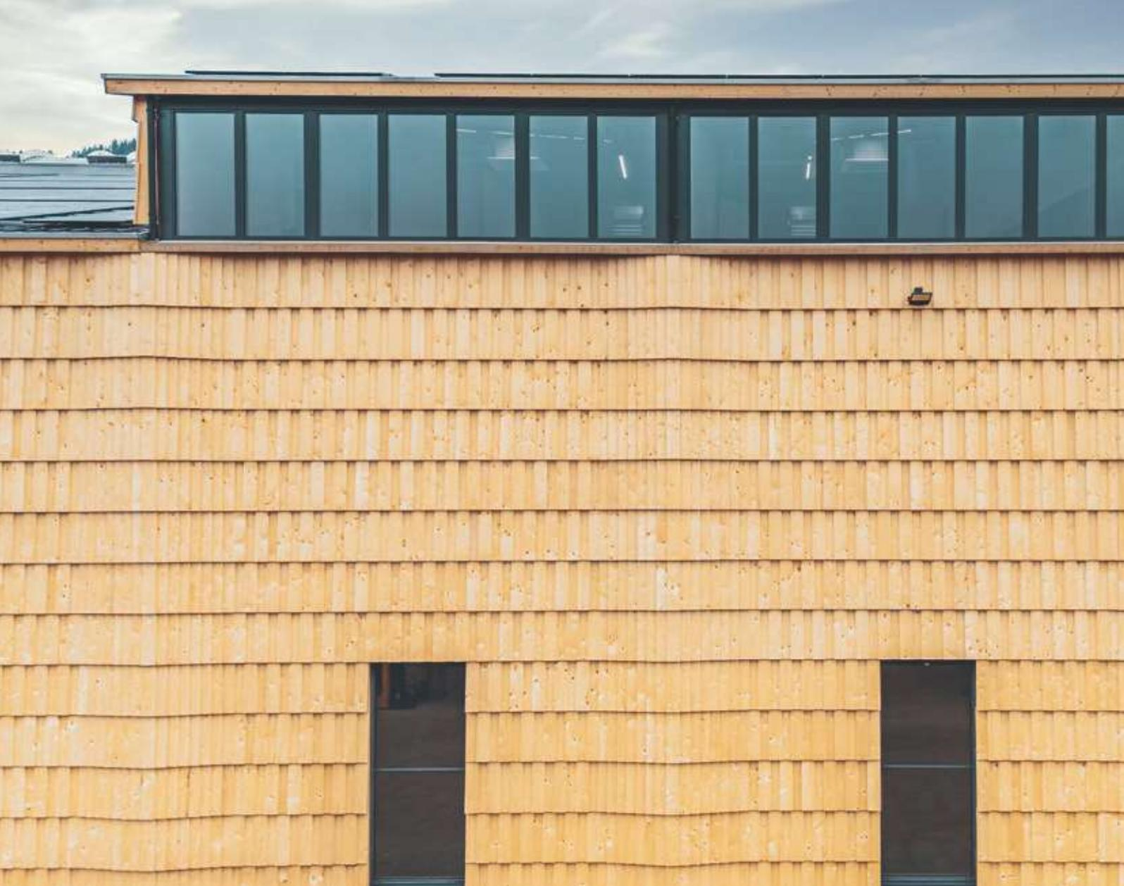
Die Nordfassade des Hochregallagers: Grossformatige Fichtenschindeln verkleiden die Holzstruktur. Darin lagern die Flaschen mit einem alkoholischen Bittergetränk.
