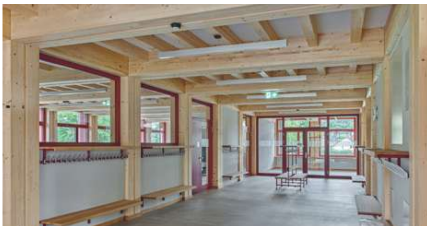
Das sichtbare Tragwerk verbindet die Klassenräume auch optisch.
