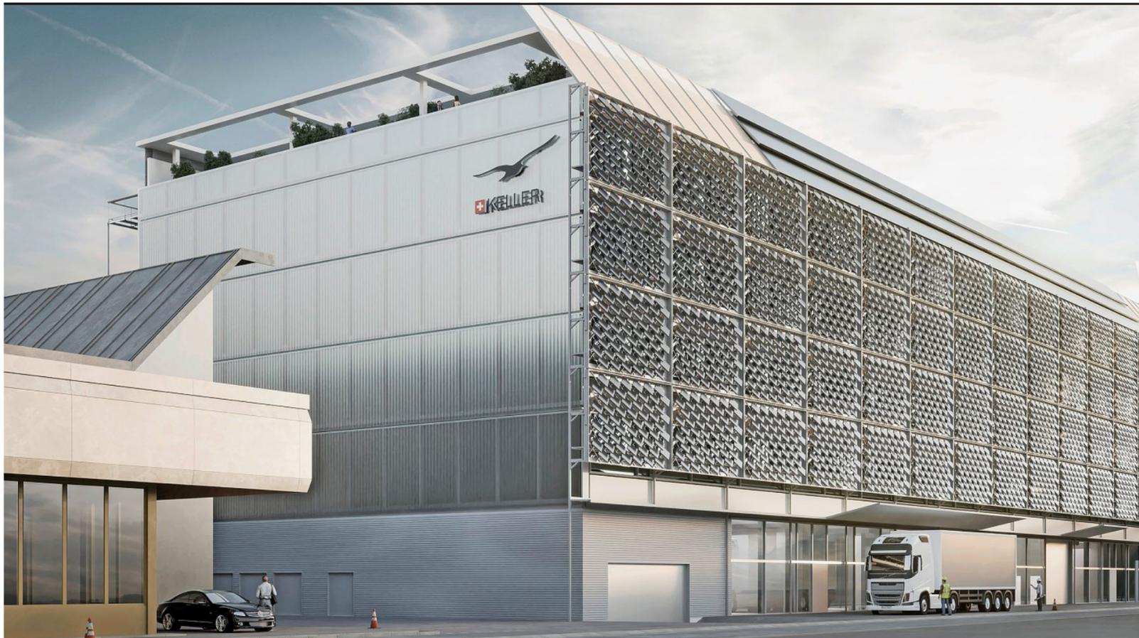
Liefen künftig 65 Prozent der Energie für die Produktion: Die schwenkbaren Fotovoltaik-Panels an der Fassade des neuen Produktionsgebäudes. Visualisierung: Strut Architekten
